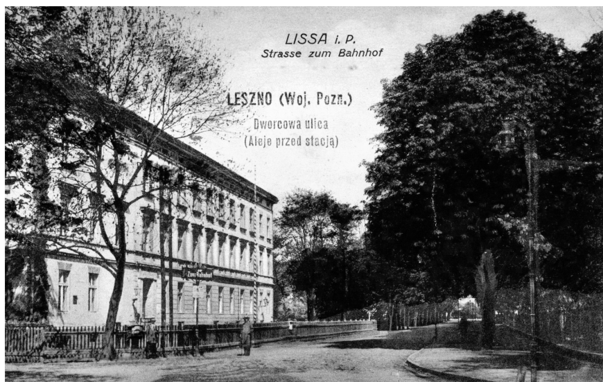
Królewski Urząd Ruchu przy ul. Dworcowej po rozbudowie w 1913 roku Źródło: ze zbiorów Marcina Błaszковского. Repr. A. Bodylska.
